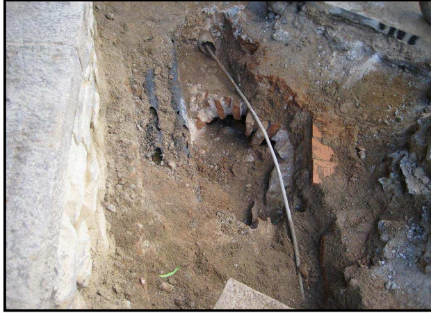
Vista NO de la cala on s'observen els tubs de telefonia i com la coberta de la claveguera està trencada
