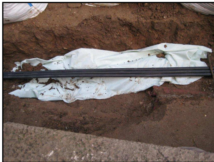
Imatge dels tubs passant per sobre les estructures
