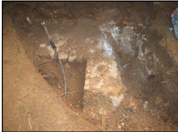
UE 110 un cop desmuntada la part que necessita l'obra per a fer passar els tubs
