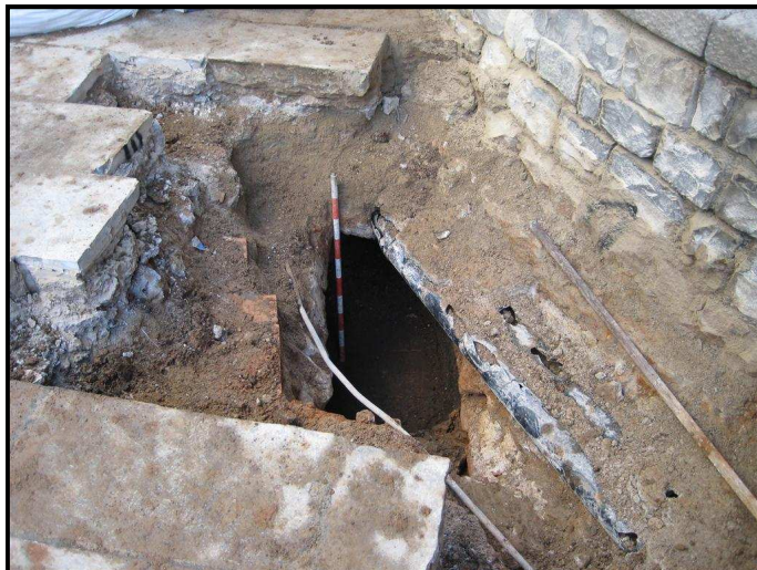
Vista SE de la cala un cop finalitzada la seva excavació
