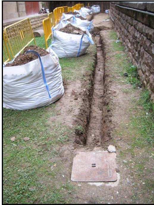
Vista NO de la rasa un cop finalitzada
