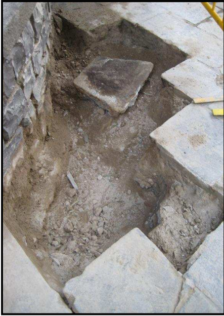
Vista NO de la cala un cop retirades les lloses del paviment actual
