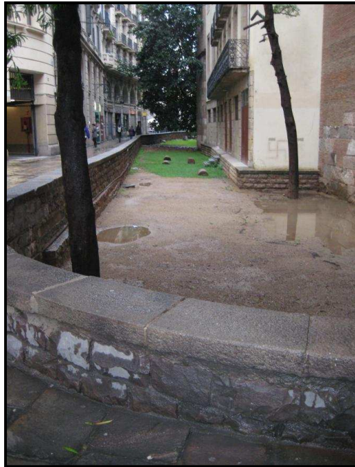
Imatge del carrer Tapineria on s'ha realitzat la intervenció
