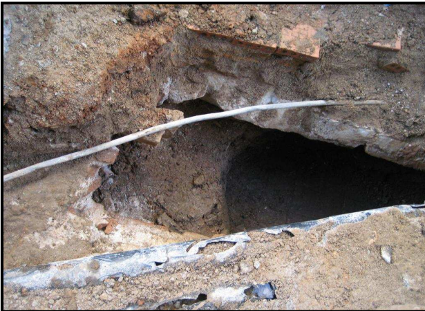
Imatge on es pot apreciar la filada de pedres de la claveguera
