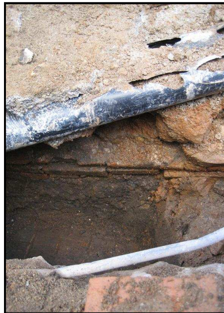
Imatge de la paret de maons i el terra de rajoles de la claveguera
